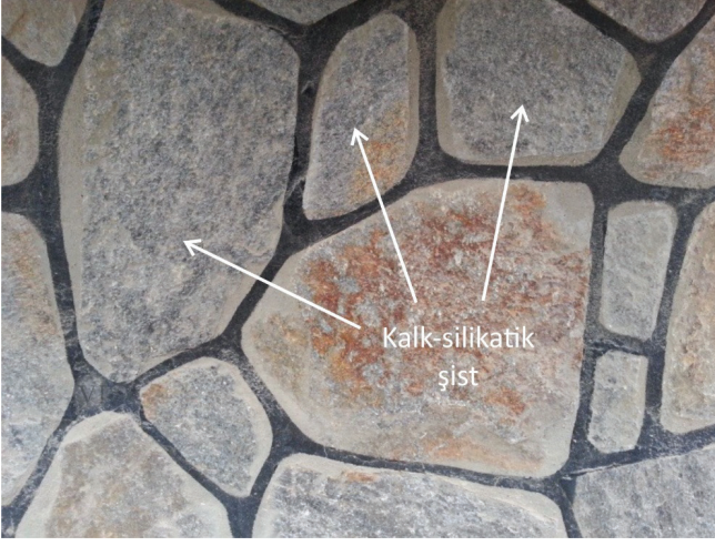
Şekil 11: Duvar kaplaması olarak kullanılan şist türü kayrak parçalarının görünümü.
